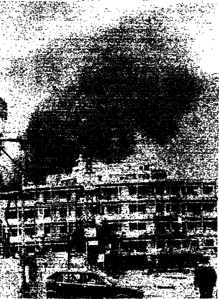
بناح حريق في الجديدة
